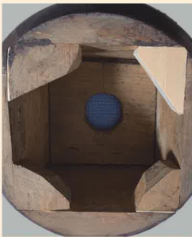
[図94]敷茄子 補強材新補 接着後
