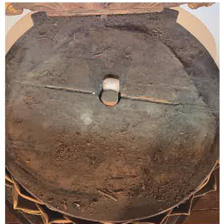
[図34]蓮肉部(上面) 亀裂
