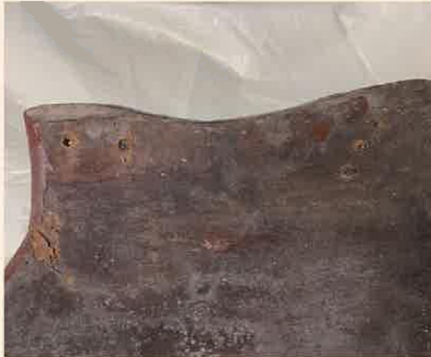
[図140]鉄釘撤去前
