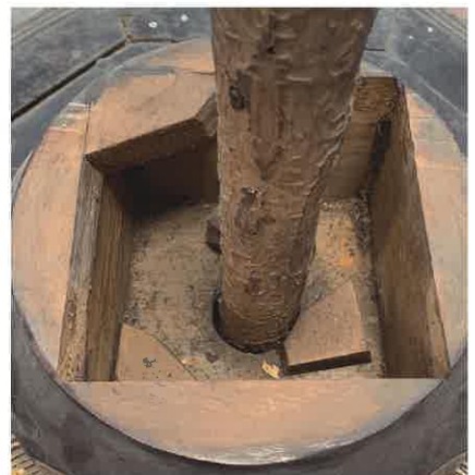
[図25]敷茄子 補強材 脱落
