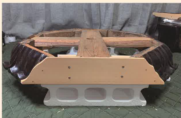
[ 図 108 ] 反花(背面) 背面材 新補後
