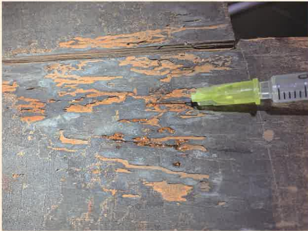
〔図168〕含浸強化処置中
