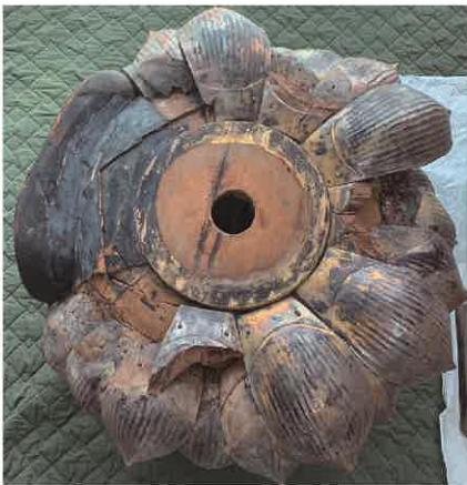
[図20]6段目の蓮弁 脱落、欠失
