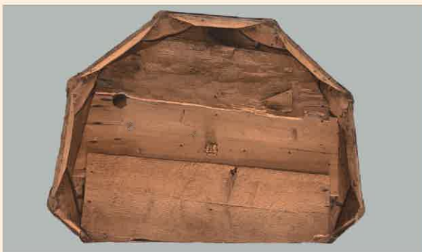
〔図69〕框 底面材撤去前
