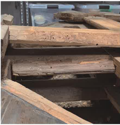
[図26]台座構造材 虫損
