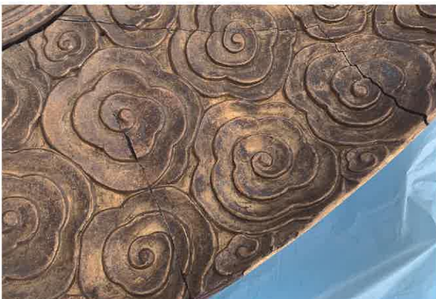
[図52]周縁部(左側) 亀裂
