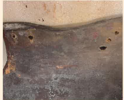
[図142]鉄釘撤去後
