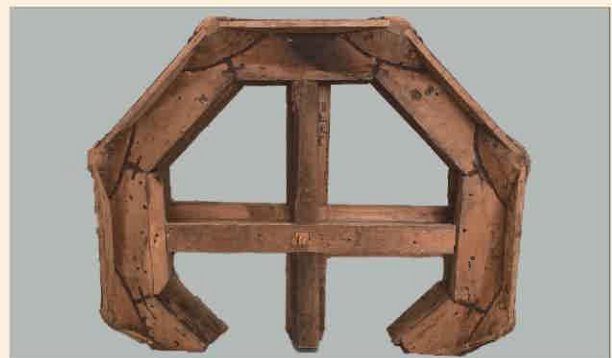
〔図70〕框 底面材撤去後
