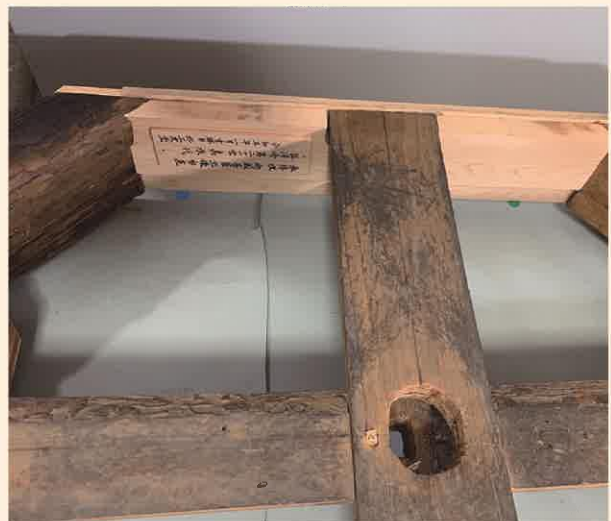
[図131]修理銘札 取り付け後
