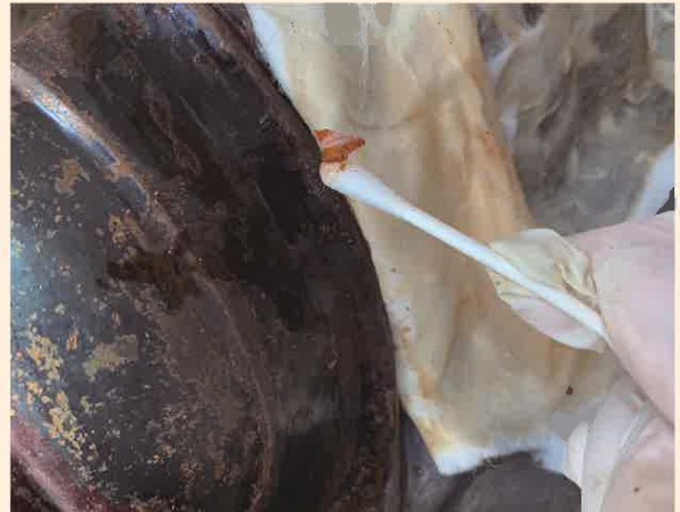
〔図75〕反花 重曹水湿布による後補塗膜除去作業
