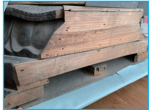
撤去予定の背面板材と底面材 (修理設計書 P,5「要確認事項」の Q4 と Q5)
