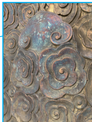
変色箇所 (修理設計書P,5の「要確認事項」Q1)
